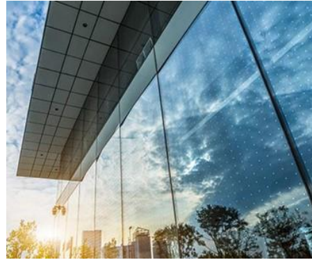
Abb. 15: Glasfassade mit Punktmuster, Quelle: SEEN AG
